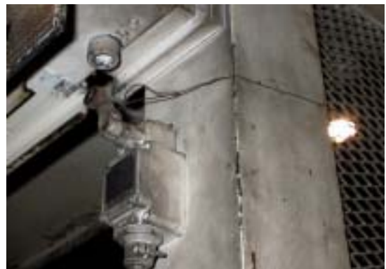
針金固定、リミットスイッチ機能停止
