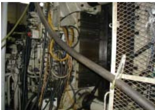
反操作側カバー開放しホースに固定
